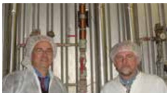
Vulcan instalado en una fábrica de alimentos
